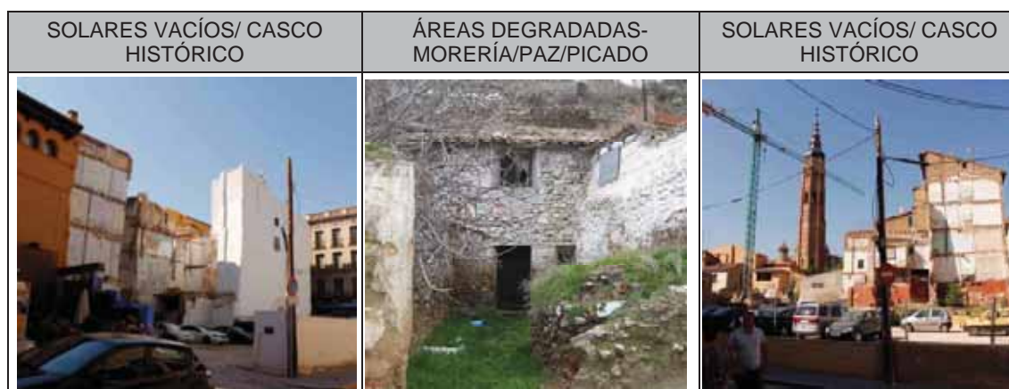
Imagen 5. Ejemplos de estado de solares, áreas degradadas del Casco Histórico y Barrio de San Antonio
